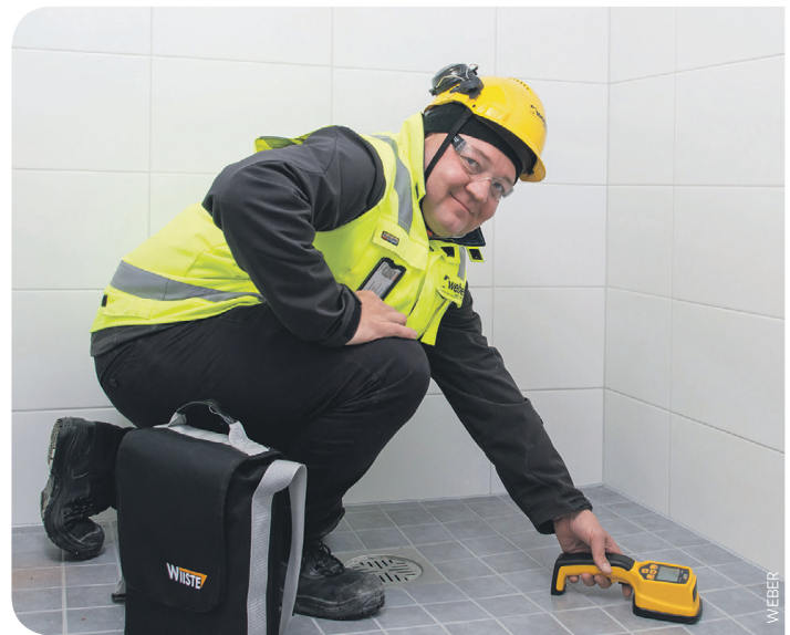
Tero Liimatainen Weberiltä mittaa lattiarakenteen kosteuden.
