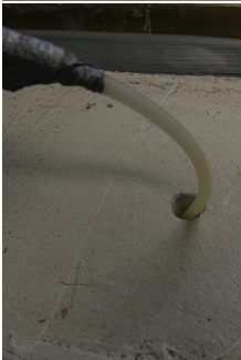
Kuva 3. Asennusreikä puhdistetaan huolellisesti imurilla käyttäen reikään mahtuvaa suutinta.
